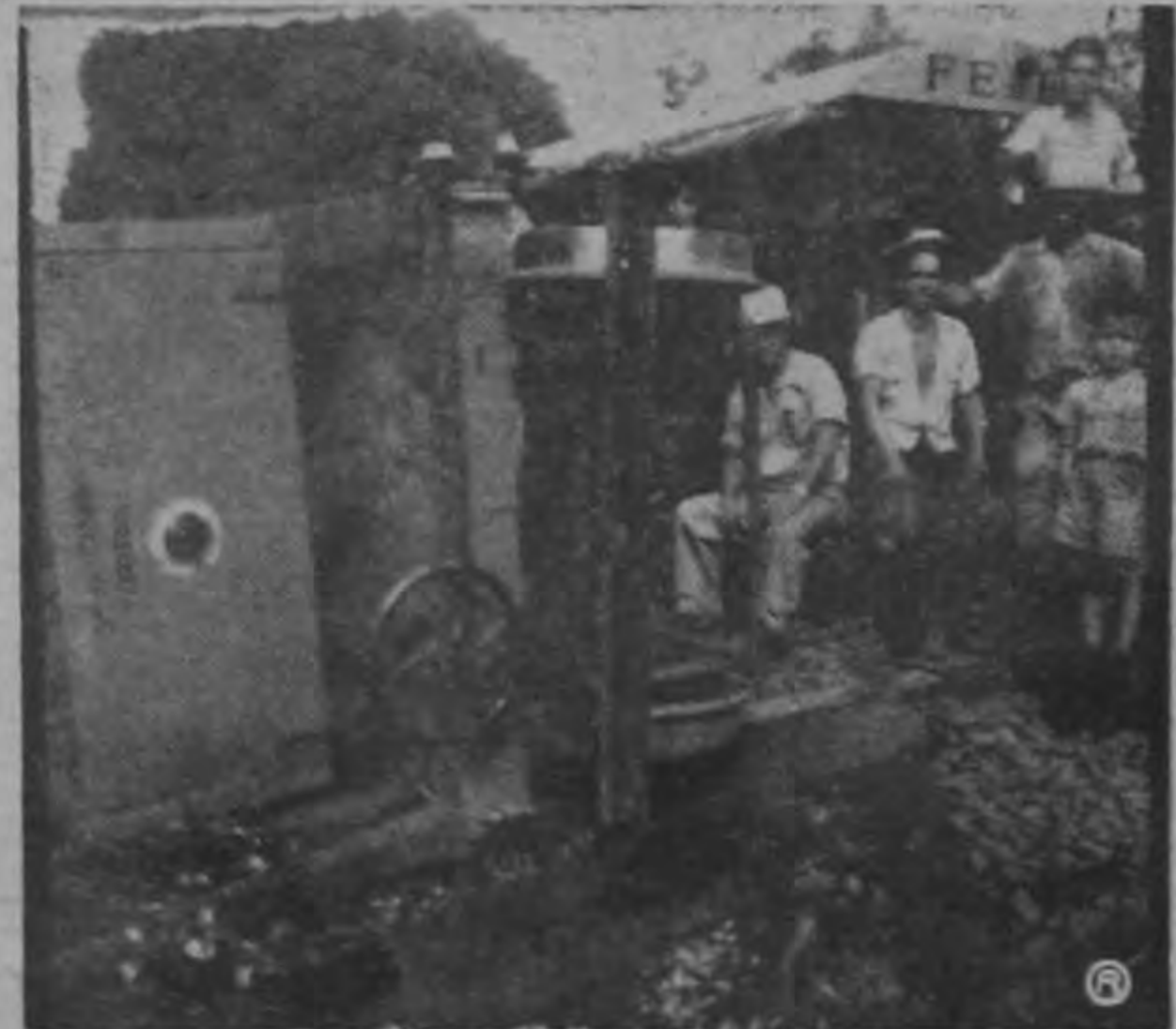
CUADRILLAS REPARAN LA VIA El carro motor que descarriló en el kilómetro 65, a la entrada de Orotina, causó destrozos en la vía, la cual está siendo reparada. En primer plano el carro torre destruido por causa del clavo introducido en los rieles. (Foto E. Alvarado)
